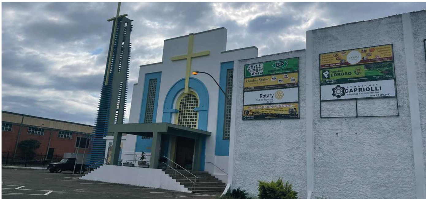
PINTURA NOVA: tinta fornecida pelo Rotary de Sapucaia do Sul
